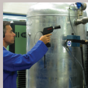
Détection de fuite par ultrasons
